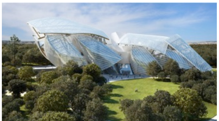
Figure 2 - Vue aérienne de la fondation Louis Vuitton à Paris
